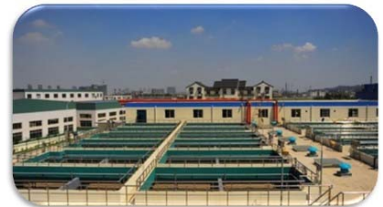
垃圾渗滤液处理系统
