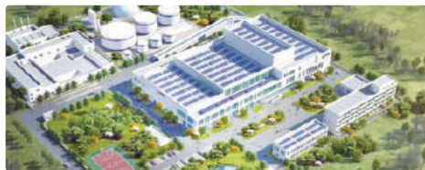
山东济南厨余垃圾资源化处置项目
