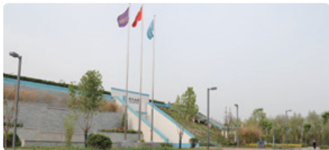
北京大兴区天堂河污水处理项目
