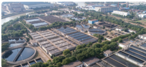
江苏江阴污水处理项目
