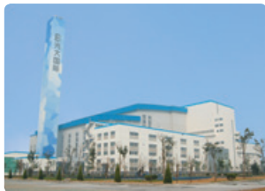
山东济南垃圾发电项目
