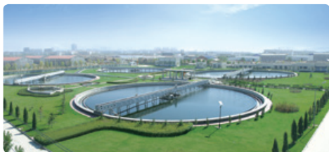
山东济南污水处理项目
