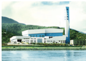
浙江宁波垃圾发电项目
