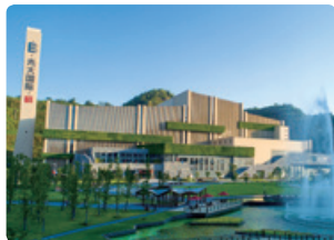
浙江杭州垃圾发电项目
