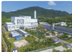
海南三亚垃圾发电项目
