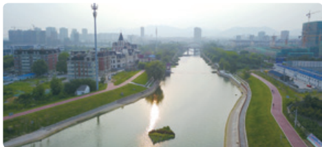
南京涉水市政工程PPP项目
