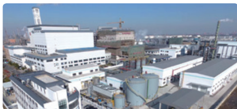
江苏常州危废焚烧项目
